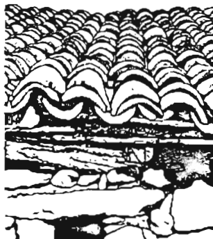
Rundziegeldach. Arosio TI
